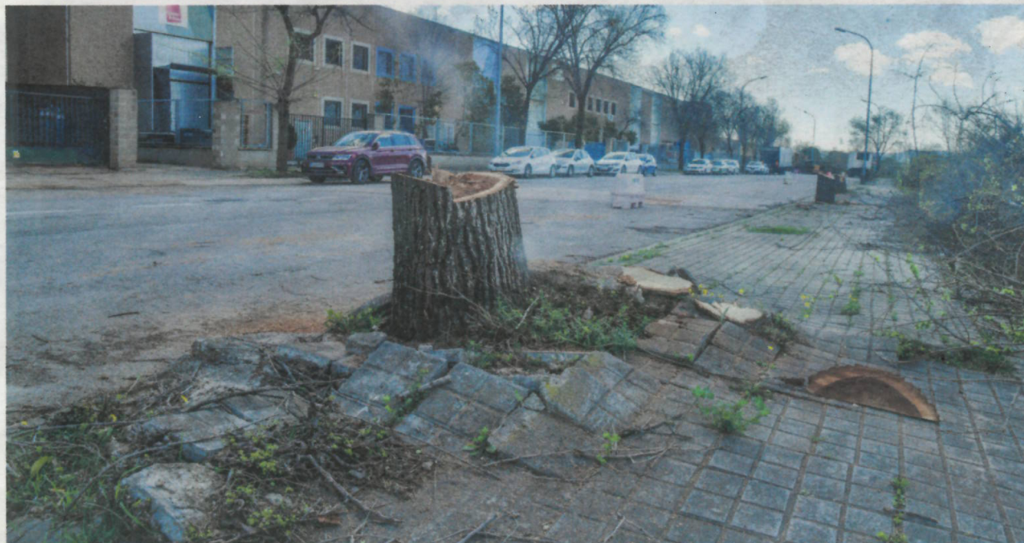
Les obres a Can Roqueta preveuen retirar tots els arbres en mal estat i reparar el ferm / LLUÍS FRANCO
